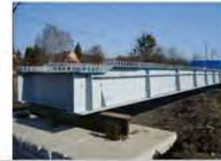
Railway bridge - Bystřice nad Olší
