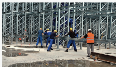
Výstavba mrazících skladů firmy Galliker ve Švýcarsku
