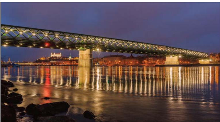
Dodávka ocelových plechů a profilů při výstavbě nového Starého mostu v Bratislavě, Slovensko, pro společnost EUROVIA CS, a.s.
