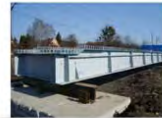
Železniční most - Bystřice nad Olší
